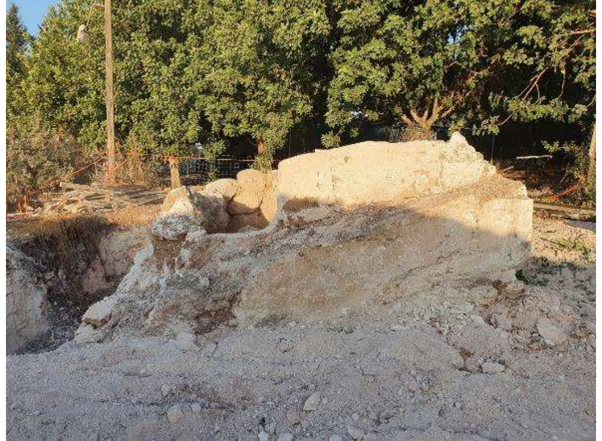
מילוי בור החפירה מסביב למקווה באדמה מקומית.
